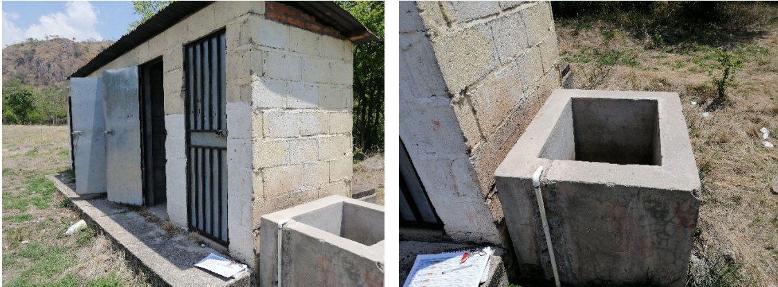
Vista anterior a demolición. Actualmente demolido.
